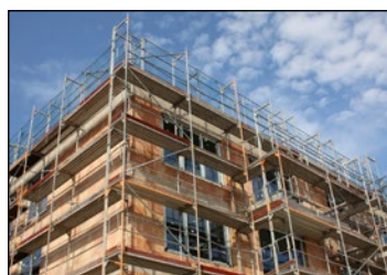
Монтаж строительных лесов
