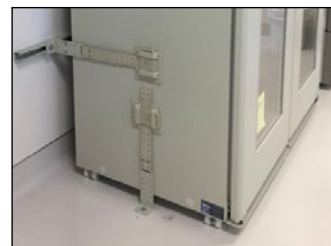
Крепление оборудования
