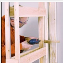
Крепление направляющих для лёгких конструкций
