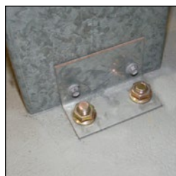
Крепление самонесущих конструкций
