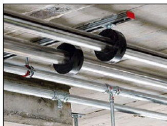
Крепление инженерных сетей
