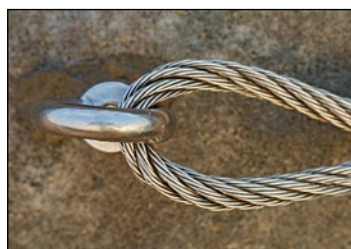
Монтаж такелажных систем
