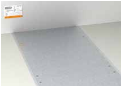
Невидимая проходка в каналах под бесшовным полом.
