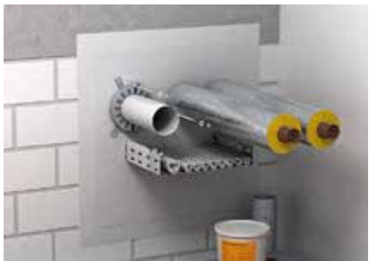
С обеих сторон с помощью шпатель зафиксировать манжеты для труб из горючих материалов.
