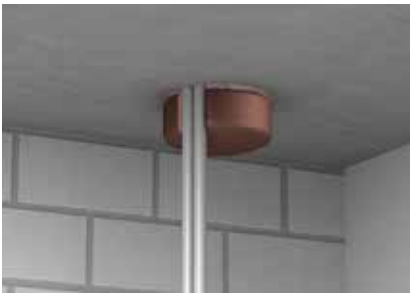
Вырезка и монтаж заглушки в перекрытие.
