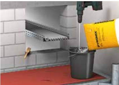
Перемешать раствор с водой до нужной консистенции в соотношении 2:1.
