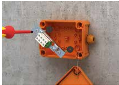
Настенный монтаж огнестойкой распределительной коробки FireBox.
