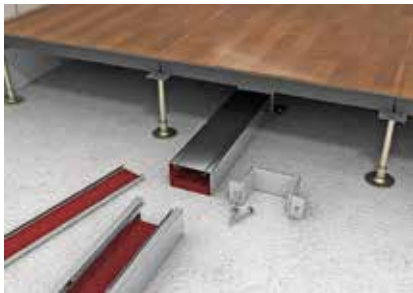
Монтаж под фальшполами.
