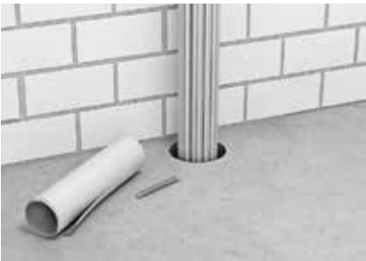
Подготовка кабельной проходки.
