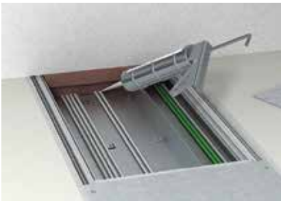
Заделать стыки шпатлевкой FBA-SP.
