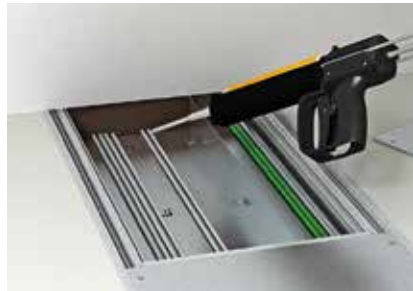
Нанесение огнестойкой пены непосредственно под стену.
