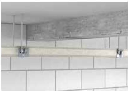
Подвесной монтаж на соединительных элементах.
