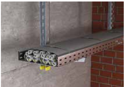
Бандажирование кабельного пучка на несущих системах.
