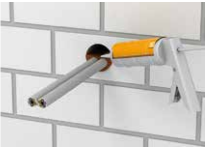
Заполнение отверстия шпатлевкой FBA-SP.
