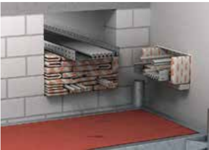
Отверстие заполняется подушками – без шпатлевки или какого-либо лакокрасочного покрытия.
