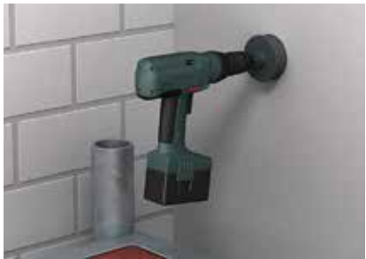
Просверлите отверстие с помощью электроинструмента.
