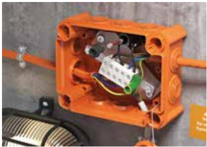
Ввод кабеля с помощью уплотнителей.
