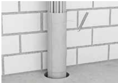
Фиксация бандаж с помощью проволоки.
