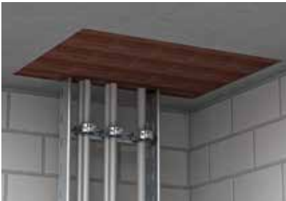
Прочная установка блоков в отверстия в перекрытии.
