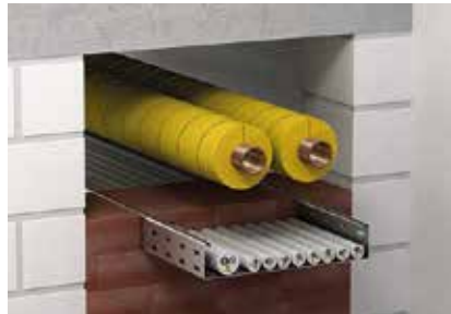
Прокладка труб из негорючих материалов с изоляцией.
