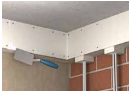
Завершающая обработка поверхности: нанесение краски или шпатлевки.
