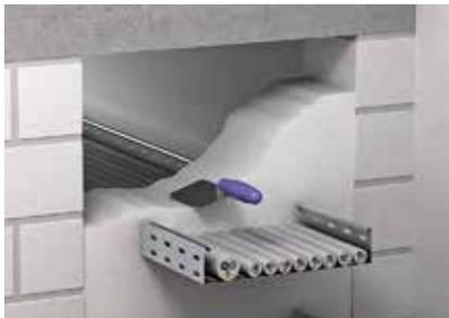
Заполните раствором отверстие, при необходимости использовать опалубку.
