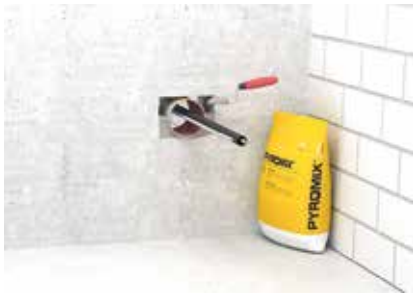
Заделка отверстия огнестойкой шпатлевкой PYROMIX®.
