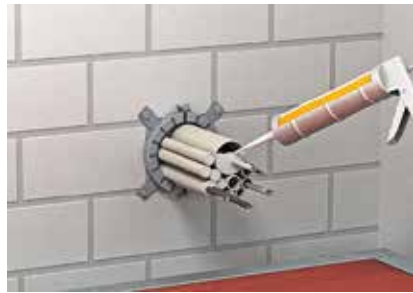
Заполнение концов труб огнестойким защитным средством DSX.
