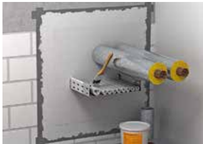
Нанести финишное покрытие на поверхность кабелей и на коммуникации.
