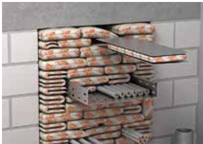
Металлические листы как вспомогательные конструкции при монтаже для последнего уровня подушек.
