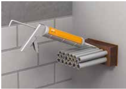
Завершающая заделка стыков по завершении прокладки кабелей шпатлевкой FBA-SP.
